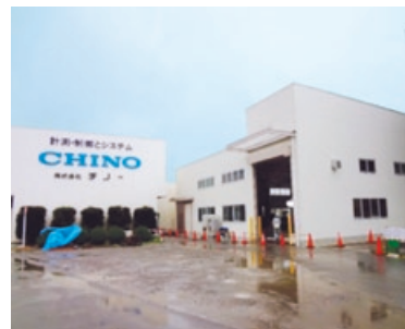
計装工場増築部分
