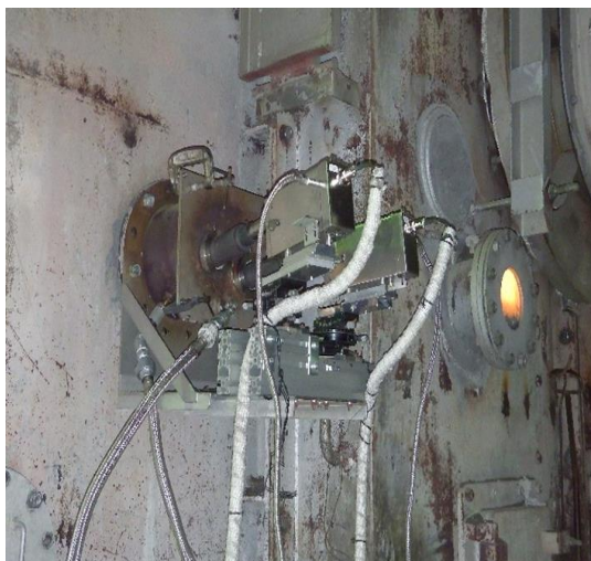
図2 設置された2台の放射温度計
